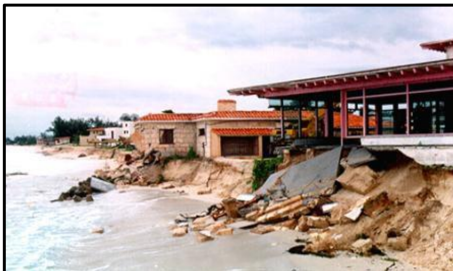
Foto 1. Instalaciones turísticas ubicadas sobre la duna en Punta Blanca, Varadero, dañadas por las olas generadas al paso del huracán Lili en septiembre de 1996.
