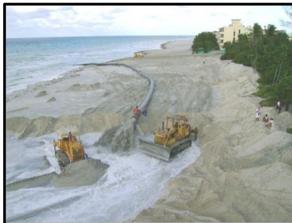
Fotos 3 y 4. Proyecto de Alimentación Artificial de Arena Varadero 1998. Dragas de succión en marcha Alpha- B de la empresa holandesa BLANEVOORT.
