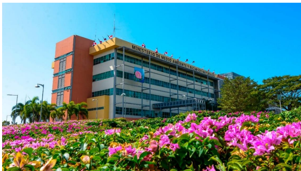
Figura 8. Edificio del Ministerio de Medio Ambiente.
