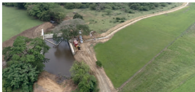
El área impactada por este sistema de riego es de 3,000 tareas.
