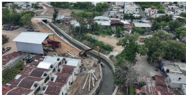
En la primera etapa se adecuó una longitud de 519.50 metros de la cañada Grande.
