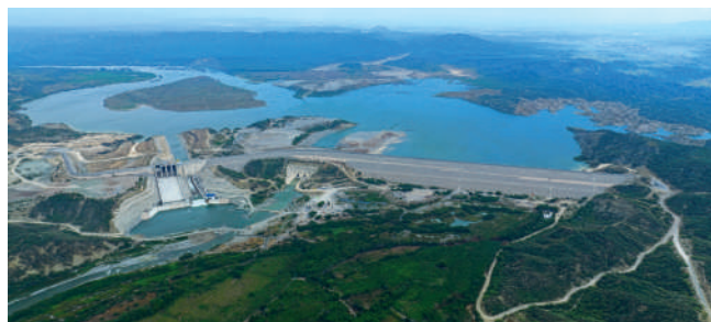
El muro o cortina de la presa Montegrande tiene una longitud de 2.2 kilómetros.
