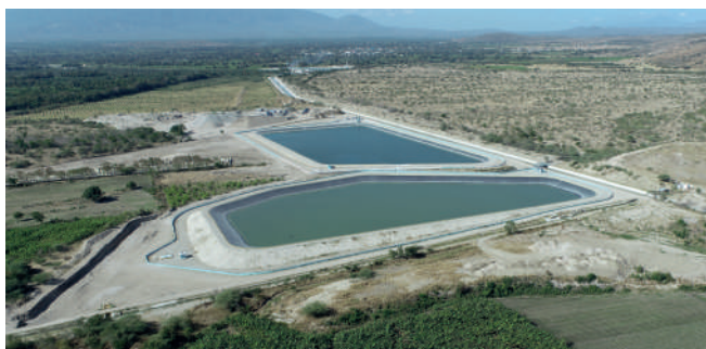
En esta Gestión del Cambio se han construido cinco reservorios y uno fue rehabilitado.
