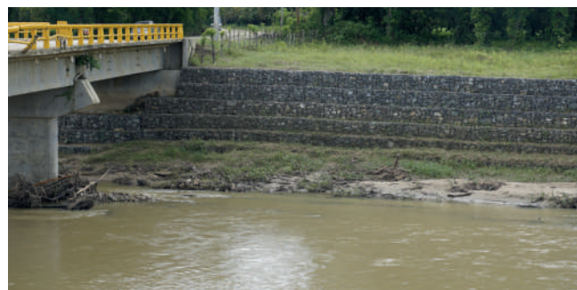
Para garantizar la seguridad de la población, fueron construidos muros de gaviones en puntos vulnerables del río Yabón.
