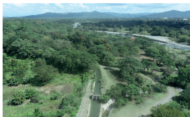
La adecuación del canal Yuna – Cañabón es otra de las obras hidráulicas contempladas en el marco de esta iniciativa.
