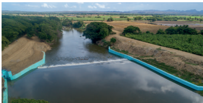
El dique de Palo Verde fue construido en el río Yaque del Norte.
