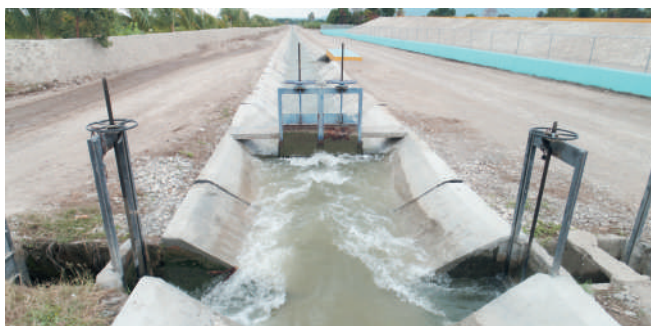
El canal YSURA fue revestido en hormigón y se instalaron 500 compuertas.
