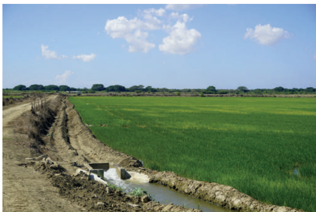
Con este proyecto se procura mejorar agro-ecosistemas productivos, conservar áreas protegidas, rehabilitar cuatro presas, mejorar servicios de riego y drenaje y construir alcantarillados sanitarios.
