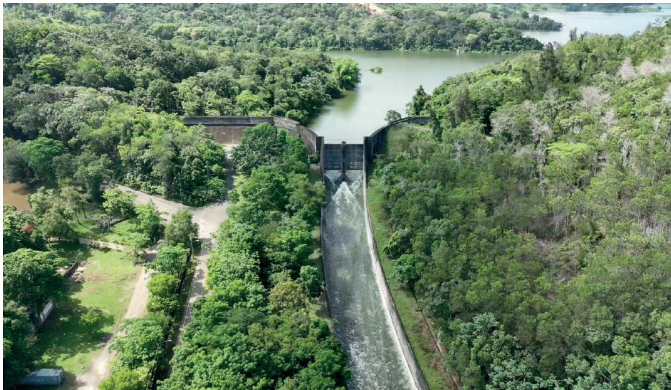
Entre las obras hidráulicas a ejecutar en el marco de este proyecto está la adecuación de la presa de Hatillo.
