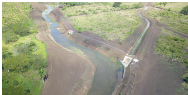
En esta primera etapa, la adecuación del río Maguá se realizó en una longitud de dos kilómetros.
