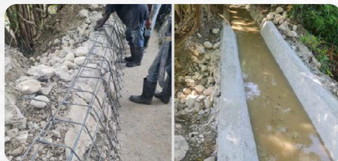
Rehabilitación del canal El Obispo, en Tamayo, Bahoruco.
