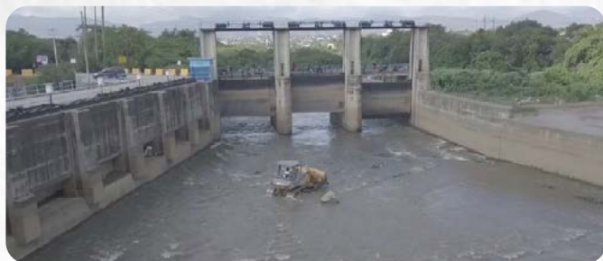
Limpieza de la obra de toma de los sistemas de riego Ulises Francisco Espailat (UFE) y Monsieur Bogaert, en Santiago.
