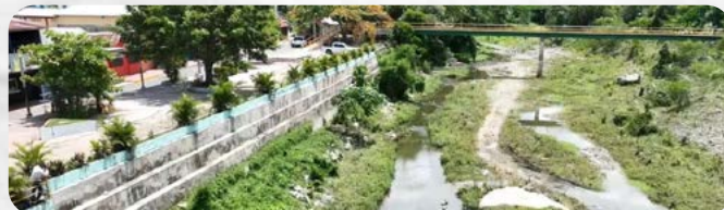
Construcción de muro de gaviones en el río Yuna, en la comunidad Los Quemados, Bonao, para evitar deslizamientos de tierra en los taludes ubicados en su margen derecha.
