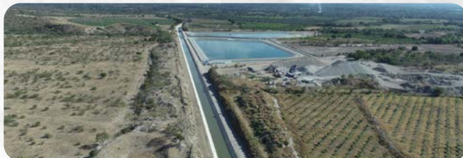
Prolongación canal Ysura en una longitud de 3.2 km para irrigar 5,184 tareas.
