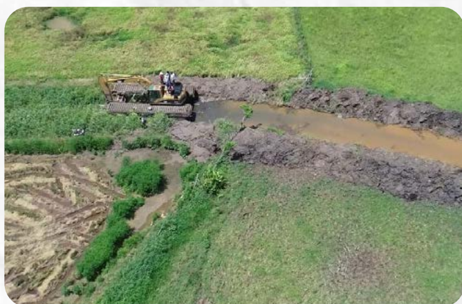
Limpieza con equipo pesado del canal Las Cejas, en Hato Mayor.
