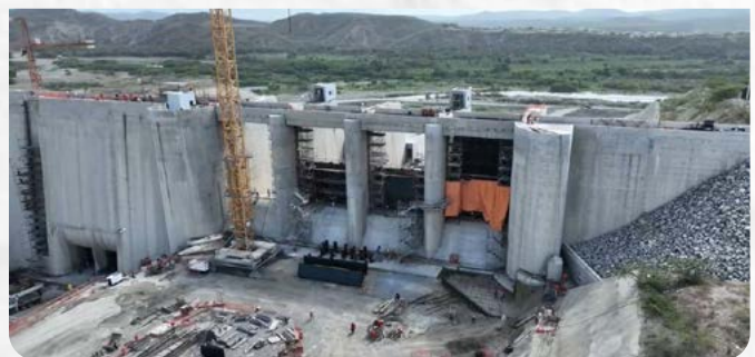
Se trabaja en la instalación de las compuertas en el vertedor de servicio.
