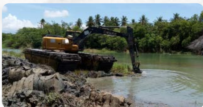
Limpieza con equipo pesado del dren Caño Trujillo, en Barahona.
