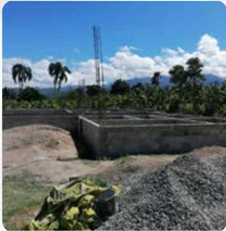
Inicio de la construcción de una funeraria en la comunidad de Los Toros, Azua.
