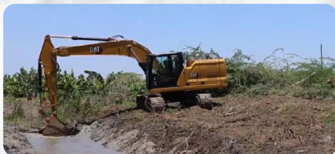
Limpieza con equipo del canal Rinconcito – Macasías, en Elías Piña.
