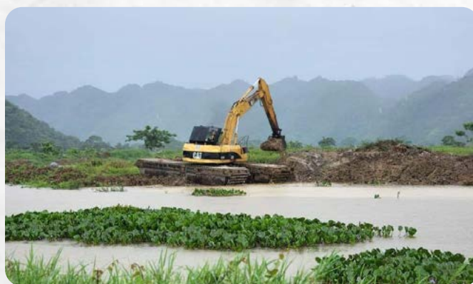
Limpieza y extracción de sedimentos con equipos pesados en la laguna Pontón, municipio de Villa Riva en la provincia Duarte, en coordinación con la Junta de Regantes de Villa Riva.
