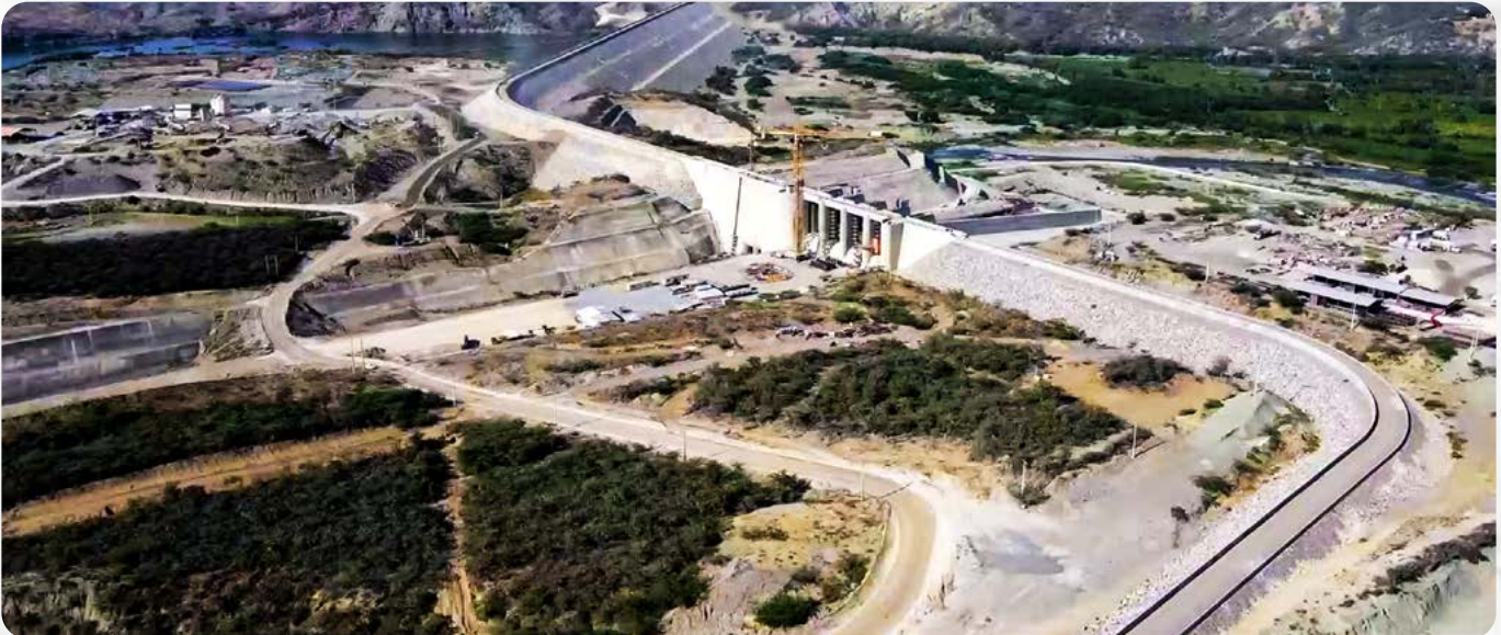
El muro con núcleo de asfalto se encuentra en la cota máxima, que es de 206 metros sobre el nivel del mar.
