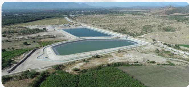
En este reservorio se instalará una línea de conducción para incorporar a la agropecuaria unas 35,000 tareas de Estebanía, Las Charcas y Hatillo.
