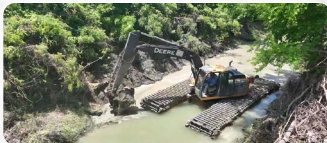
Limpieza de drenaje en Bahoruco.
