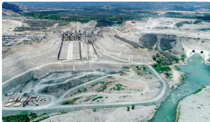
Vista panorámica de la obra magna presa Montegrando.
