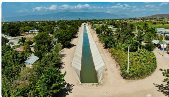
Rehabilitación del canal Padre Las Casas II, Azua.
