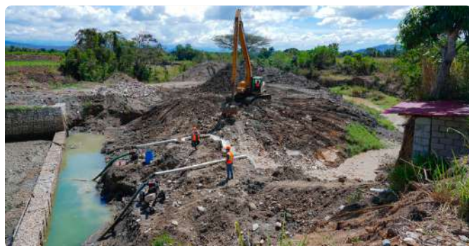
Construcción de un dique y una obra de toma en el río Yábano.
