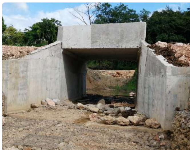
Construcción de una alcantarilla de cajón en Cueva de Cevicos, Villa Riva.
