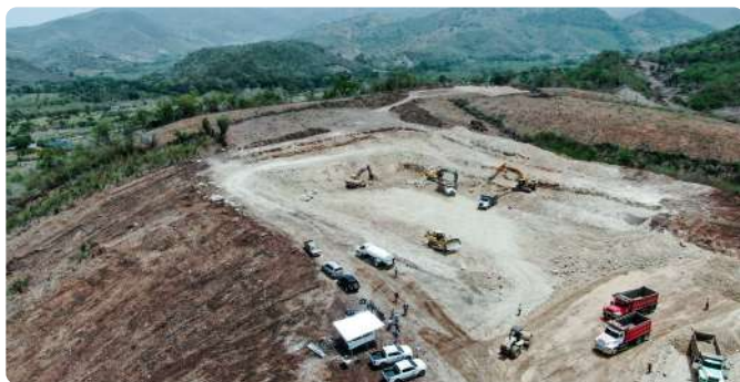
Construcción del Sistema de Riego Altos de Las Yayas, Azua.
