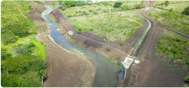
Vista aérea de los trabajos finalizados de adecuación y protección del río Maguá, provincia Hato Mayor.
