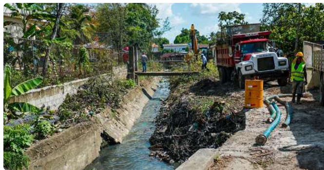
Rehabilitación del canal Pantuflas, sector El Cercado en Constanza.
