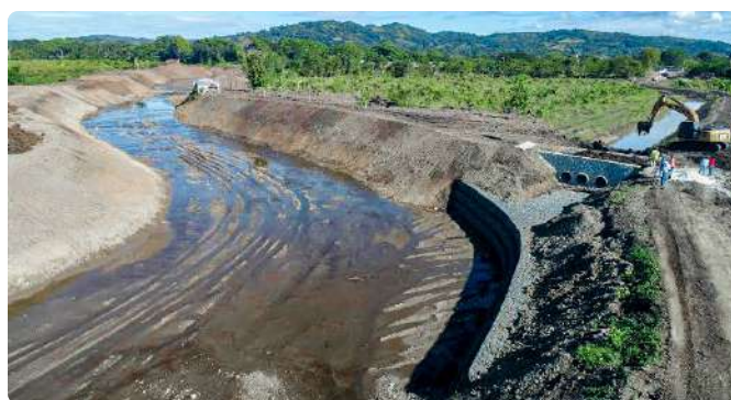
Adecuación y protección del río Maguá en Hato Mayor.
