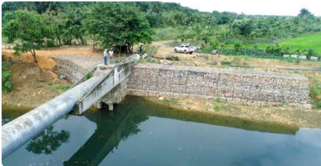
Construcción de un muro de gaviones en el río Nisibón, provincia Higüey.
