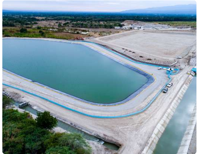
Vista aérea del reservorio V, provincia Azua.
