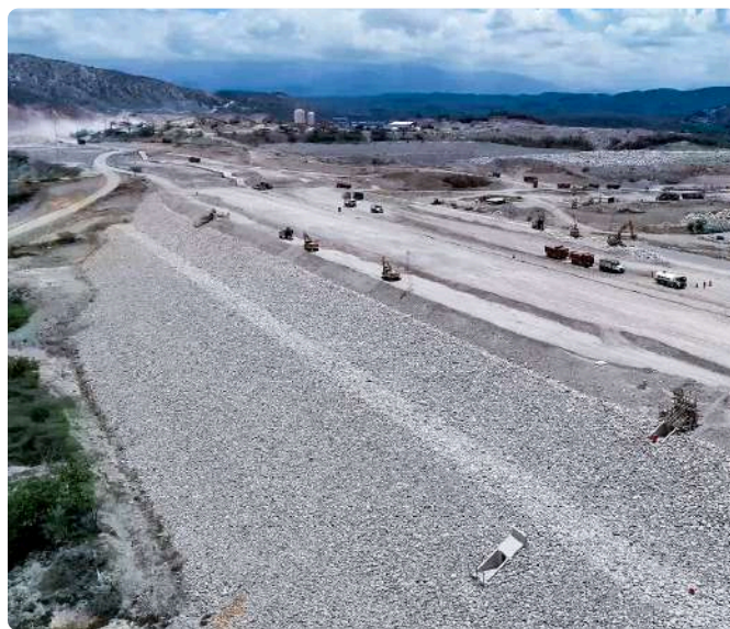
Vista aérea del muro y núcleo de asfalto de la presa en construcción.
