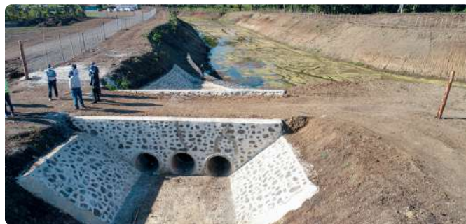
Rehabilitación del canal Maguá – Cañita, provincia Hato Mayor.
