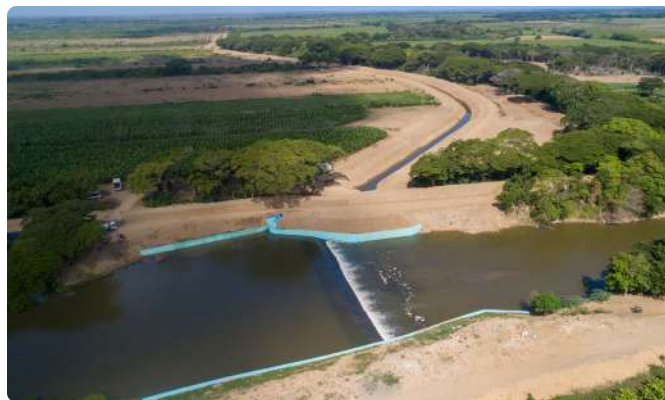
Dique y canales finalizados en Palo Verde, provincia Montecristi.
