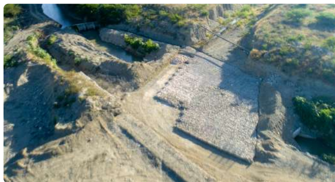
Vista aérea del puente alcantarilla en la intersección del arroyo Buringa con el canal Vicente Noble.
