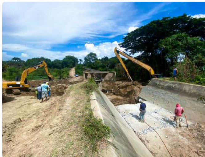
Reparación del canal Monsieur Bogaert en Los Almácigos.
