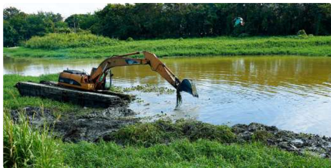
Labor de limpieza en la obra de toma de los canales Ms. Bogaert y Ulises Francisco Espaillet, en Santiago.
