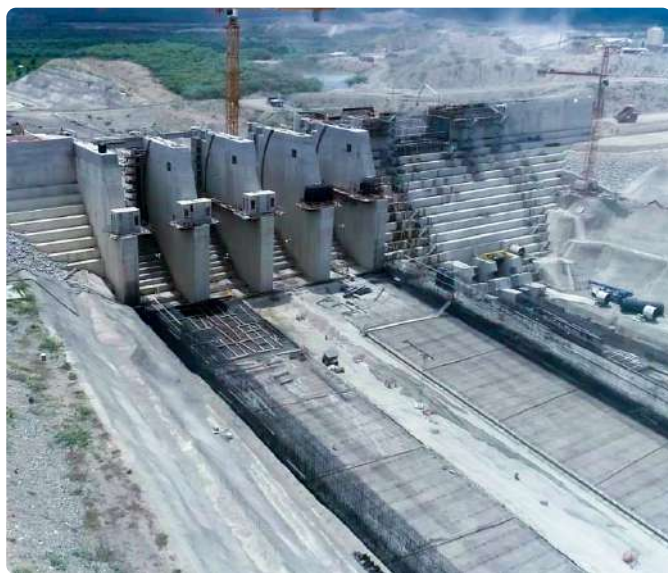
Vista del vertedor de servicio en la construcción de la presa Montegrando.
