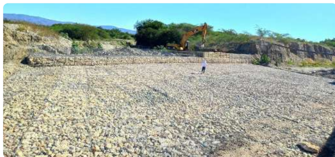
Contrucción del muro de gaviones en el puente alcantarilla, Vicente Noble.
