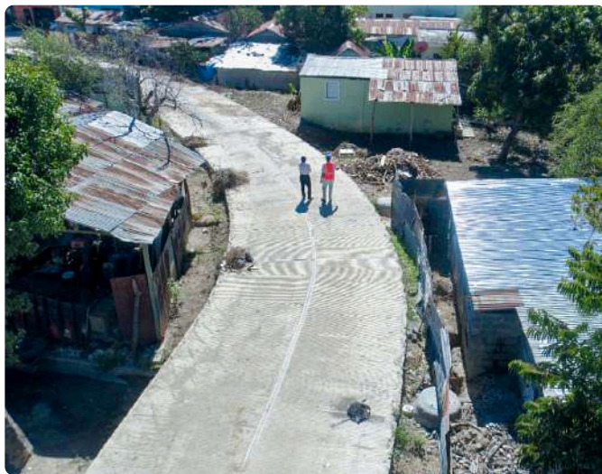
Tramo revestido de la cañada Tengerengue en San Juan de la Maguana.
