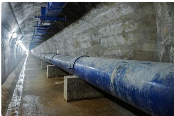
Interconexión finalizada del canal Juan Calvo con el lateral 0, en Dajabón.
