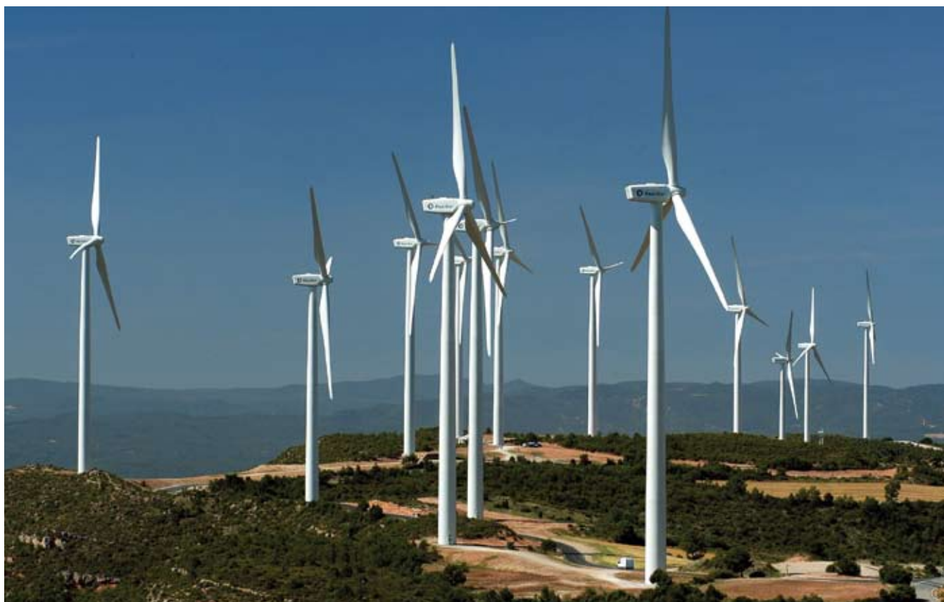
Los proyectos de generación eólica pendientes del otorgamiento de la concesión definitiva suman una capacidad de alrededor de 500 MW.
