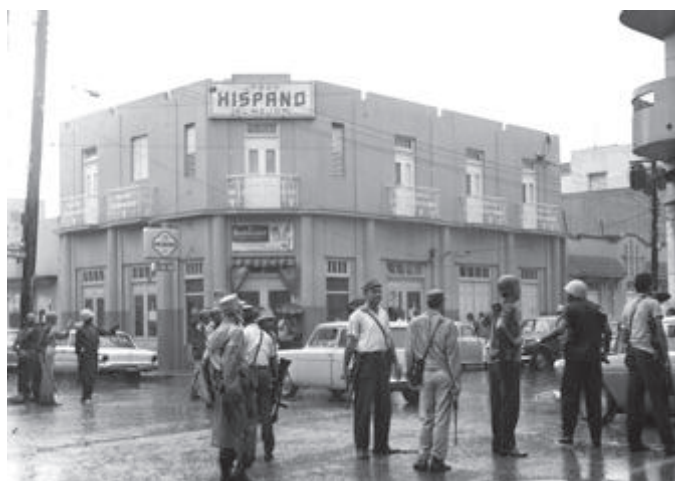
Calle Palo Hincado esq. Arzobispo Nouel
