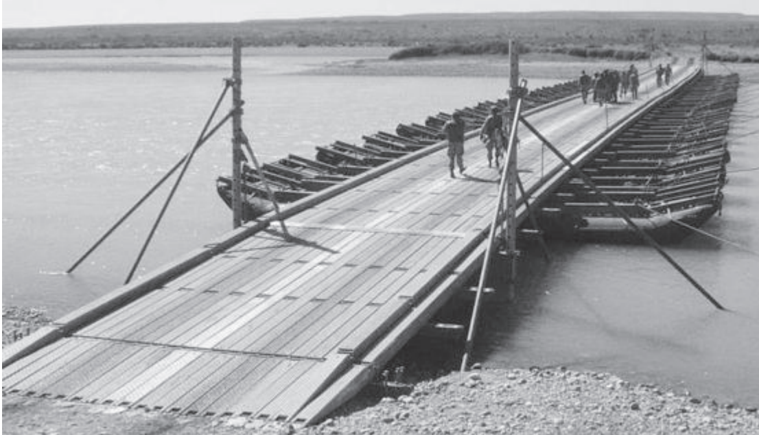
Inutilizado el puente sobre el río Haina, los yanquis instalaron un puente apoyado en barcazas para movilizar los pertrechos bélicos que desembarcaron en esa comunidad y abrir el tránsito a vehículos de civiles.
