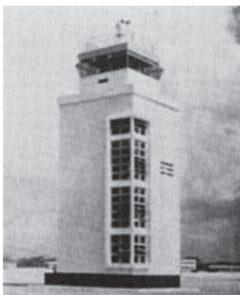
Torre de control San Isidro
