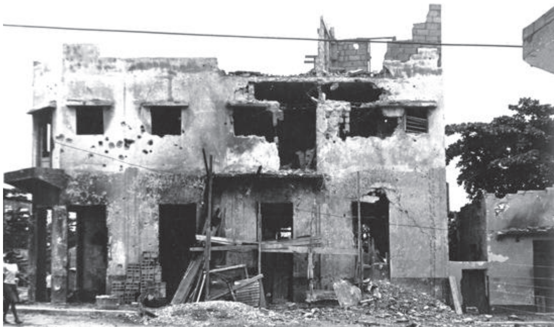
Edificio destruido por los ataques
