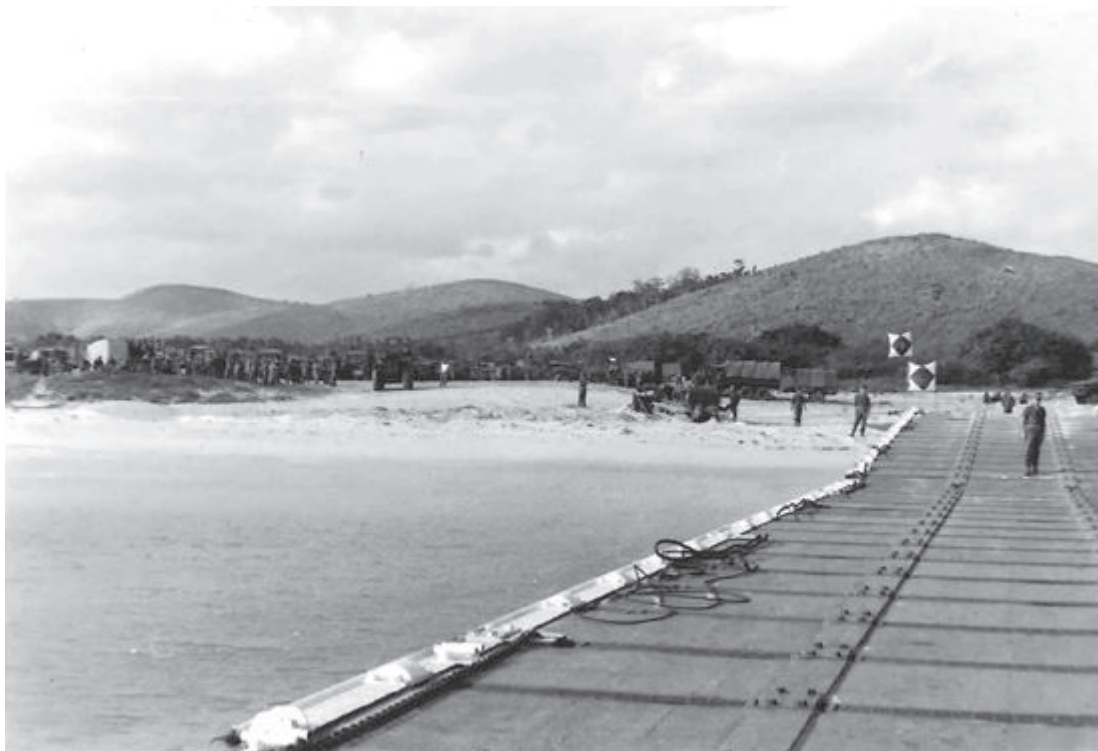
Rampa instalada para sacar vehículos y tropas desde el barco a la playa de Haina
