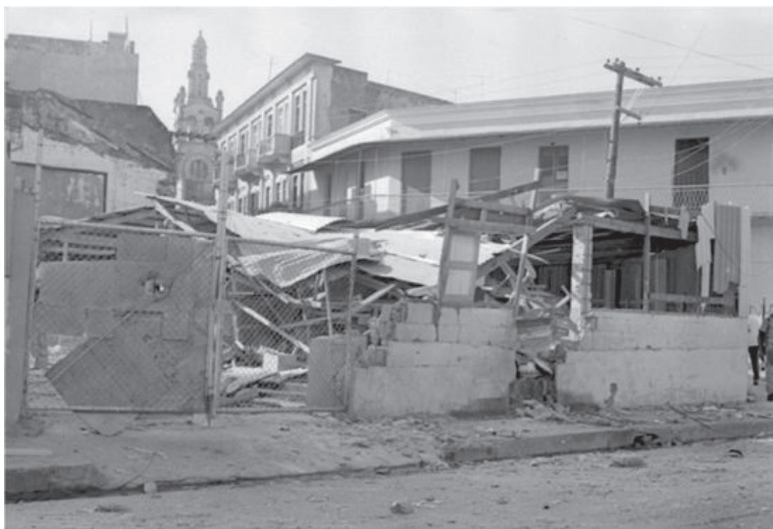
Edificaciones destruidas por el bombardeo de las fuerzas enemigas
