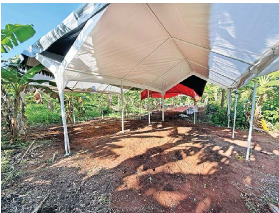
Zona de excavación preparada con carpas que protegieron toda el área de trabajo.
