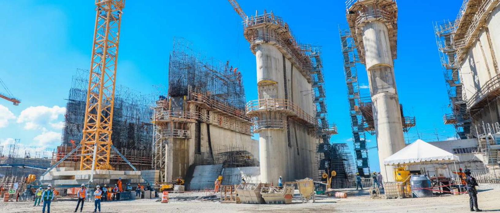
Avances realizados en el Vertedero de Servicio, componente de la construcción de la presa Montegrande.
