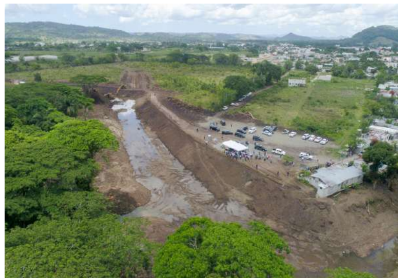
Ampliación del cauce del río Maguá, en Hato Mayor.
