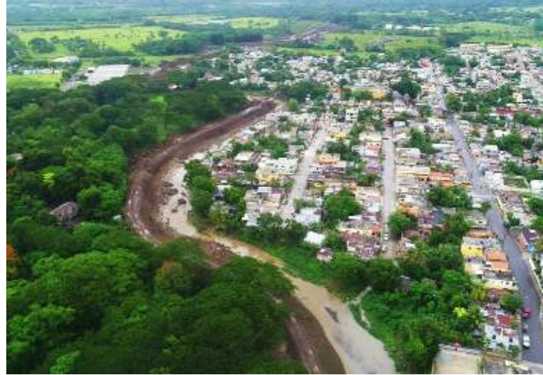
Vista aérea de los sectores beneficiados con los trabajos de adecuación.
