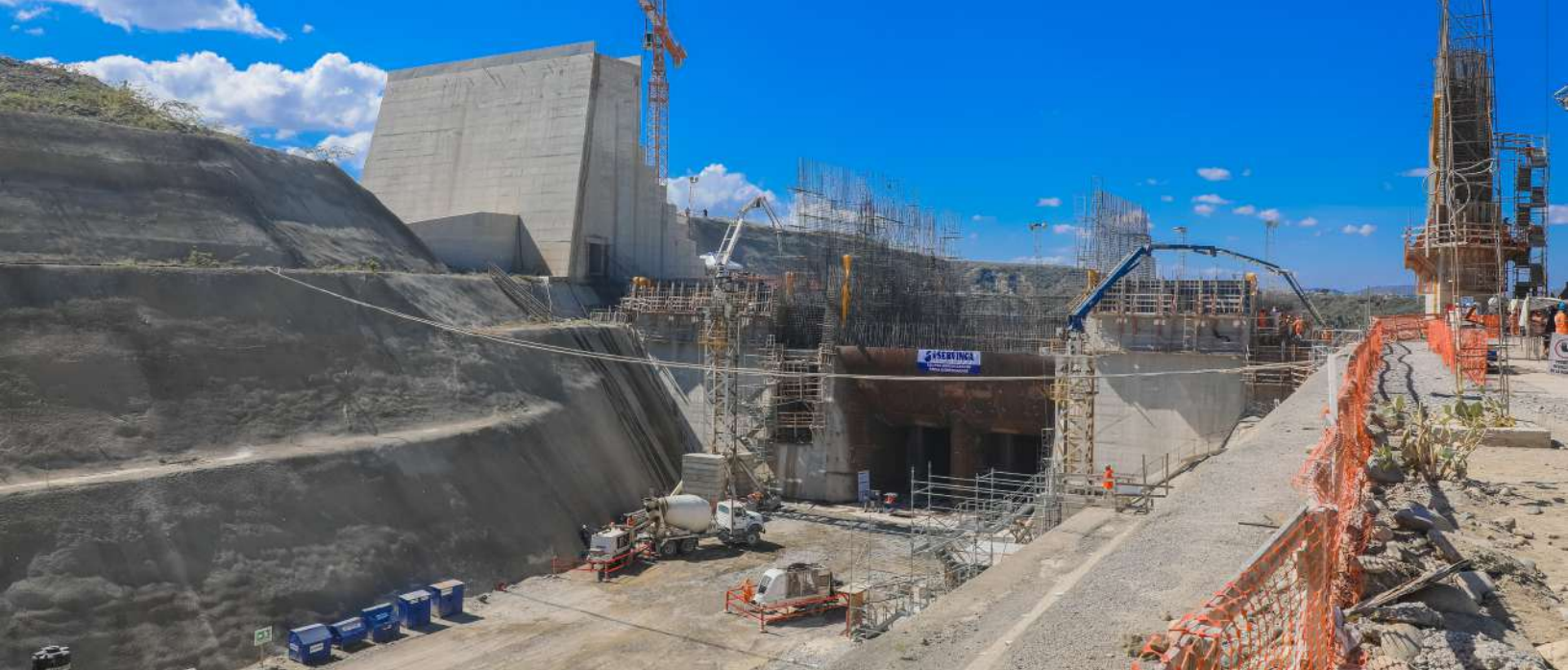
Construcción del Desagüe de Fondo de la presa Montegrande.
