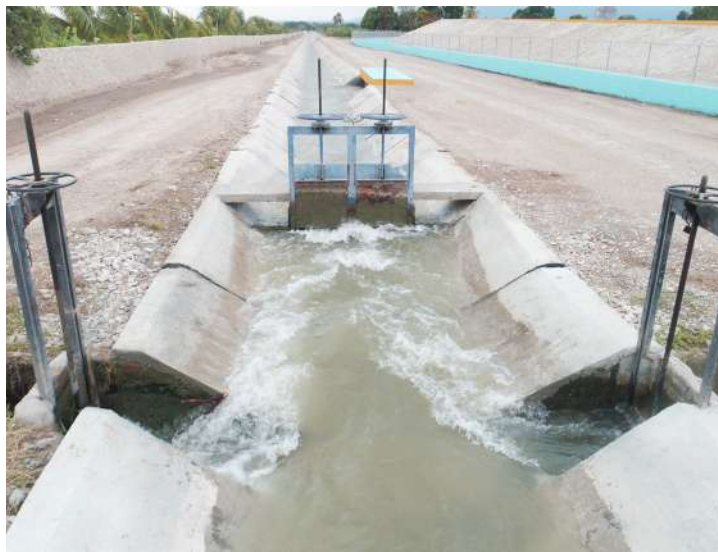
Obra de toma del Reservorio V.
