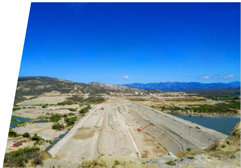
Vista panorámica del área de la presa en construcción.
