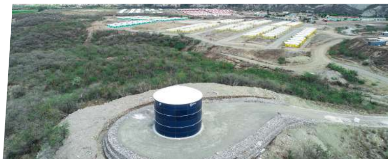
Instalación del acueducto en el Centro Poblado.
