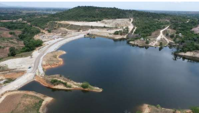
Vista panorámica de la Presa La Piña en Dajabón.
