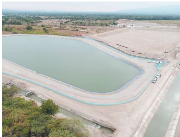
Vista aérea del Reservorio V.
