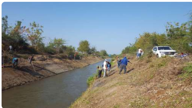
Durante los trabajos de limpieza del canal Fernando Valerio.
