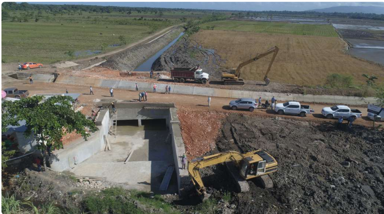
Construcción del puente alcantarilla y trabajos de adecuación del canal principal en El Aguacate, Bajo Yuna.
