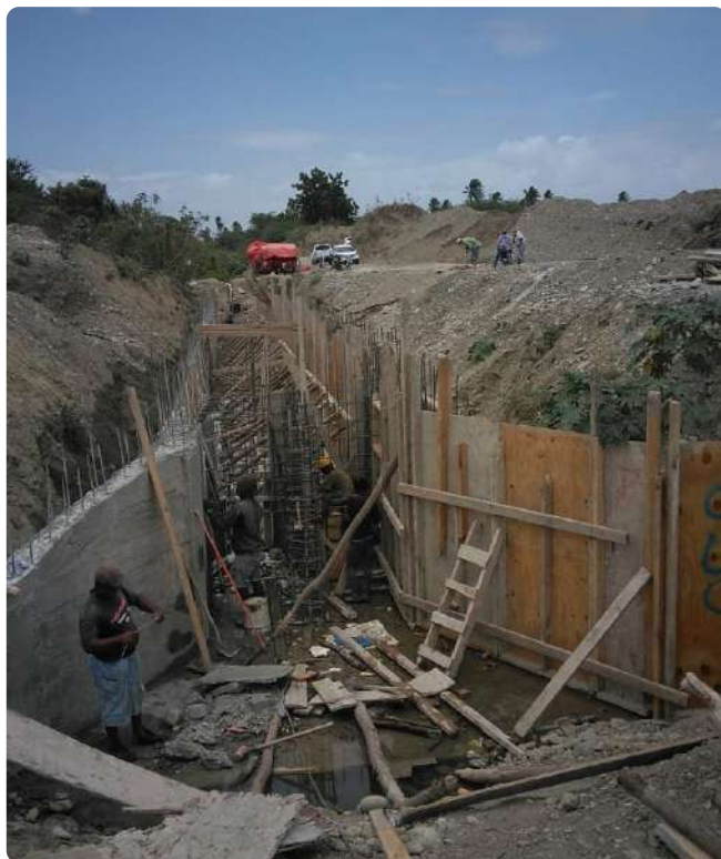
Trabajos de adecuación de la alcantarilla cajón en la desembocadura del arroyo Buringa. Vicente Noble, provincia Barahona.
