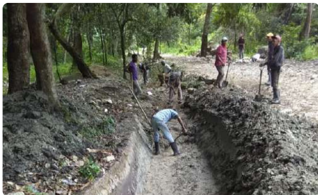
Trabajos de limpieza en el Sistema de Riego Lago Enriquillo.
