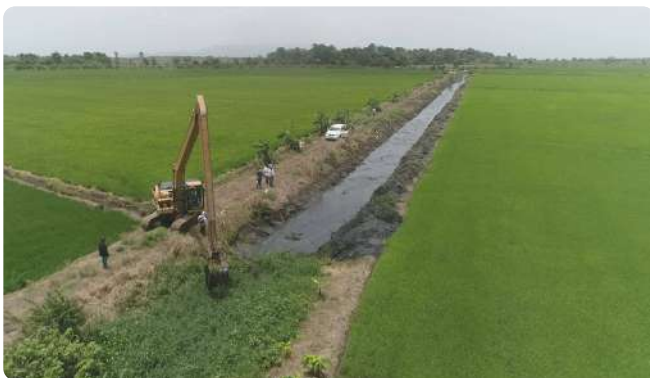
Trabajos de limpieza en el drenaje de Caño Guayabo en el municipio de Arenoso, provincia Duarte.
