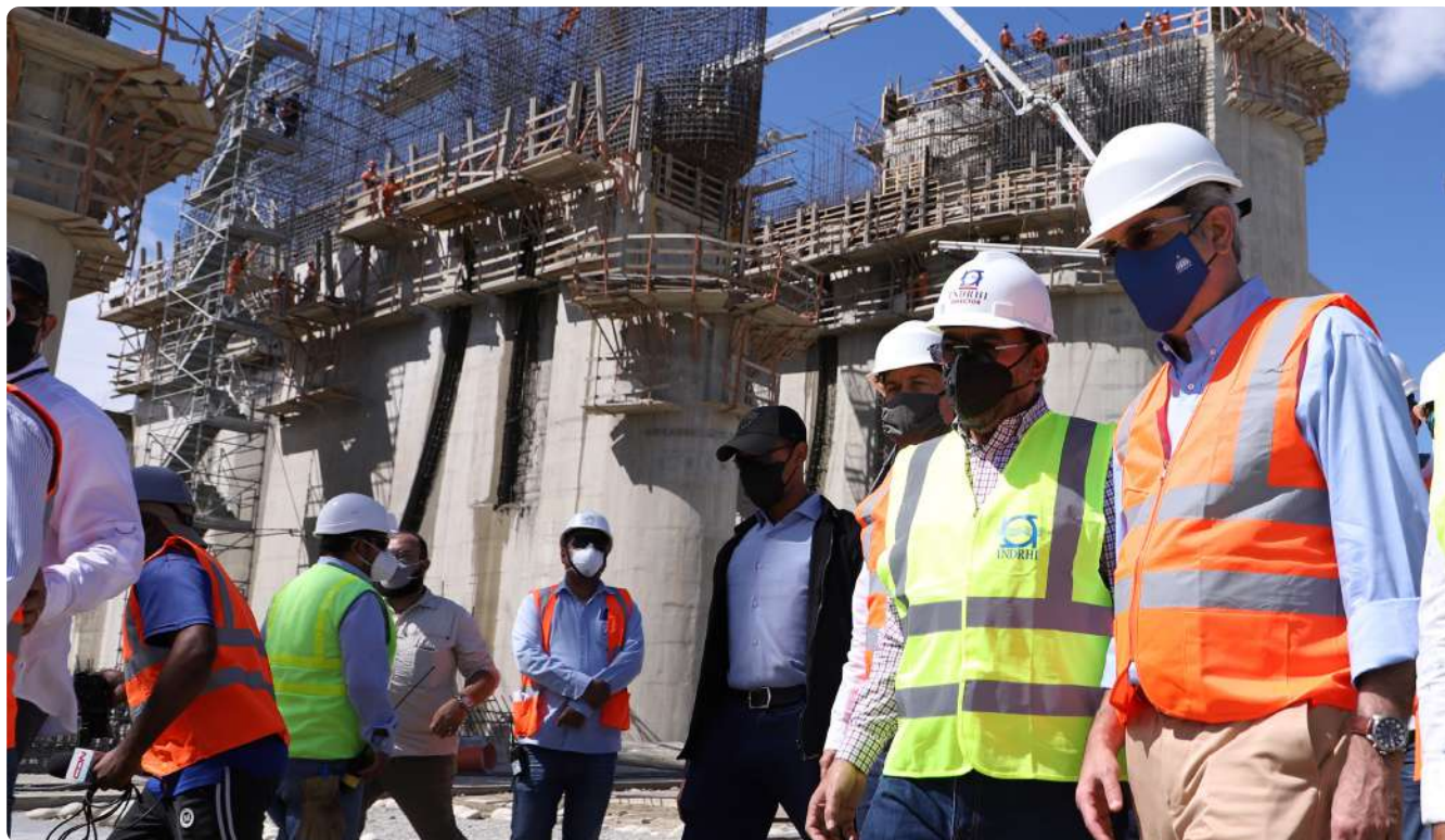
El presidente Luis Abinader, en compañía del director ejecutivo del INDRHI, Olmedo Caba, inspecciona los trabajos que se realizan en el Proyecto Múltiple Presa Montegrando.
