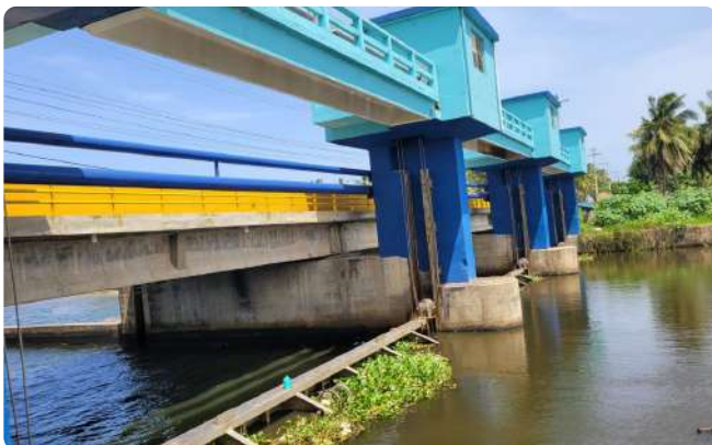
Adecuación del sistema de compuertas contramarea en el puente Nagua, provincia María Trinidad Sánchez.
