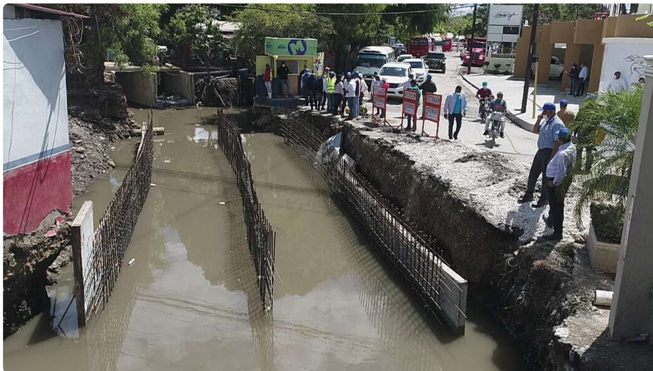
Durante los trabajos de rehabilitación de la cañada Tengerengue, provincia San Juan.
