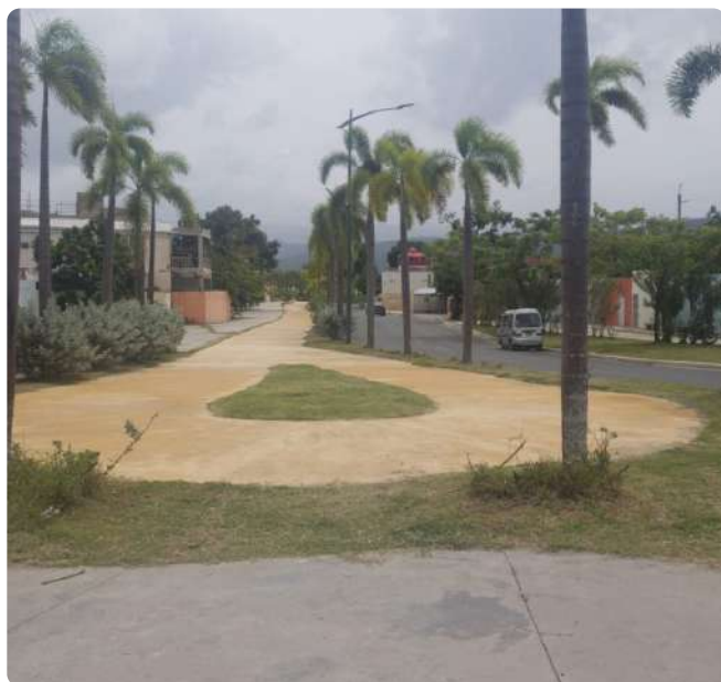
Trabajos de terminación del parque El Riito, La Vega.
