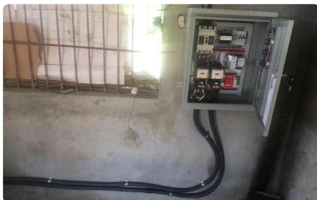
Instalación y electrificación de bombas.
