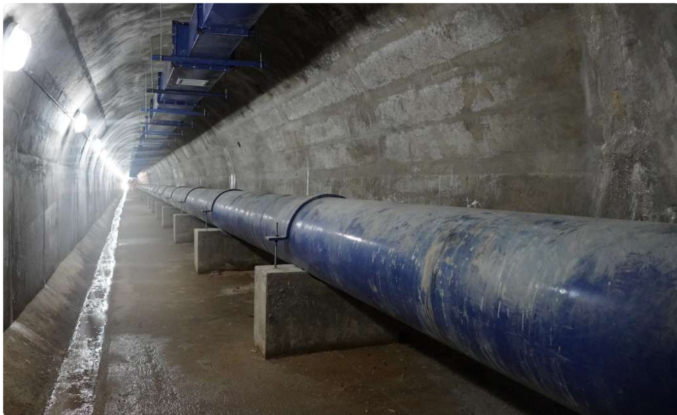
Interconexión finalizada del canal Juan Calvo con el lateral 0, en Dajabón.
