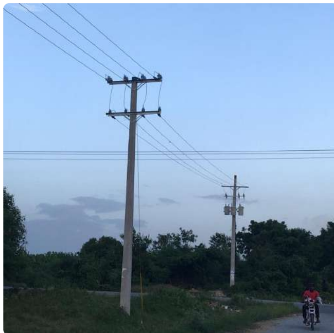
Instalación de electrificación trifásica, Proyecto 2C.
