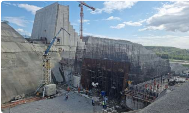
Construcción de la obra de toma de agua, presa Montegrande.
