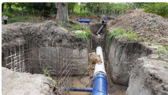
Durante la instalación de la interconexión del canal Juan Calvo, con el lateral 0, en Dajabón.
