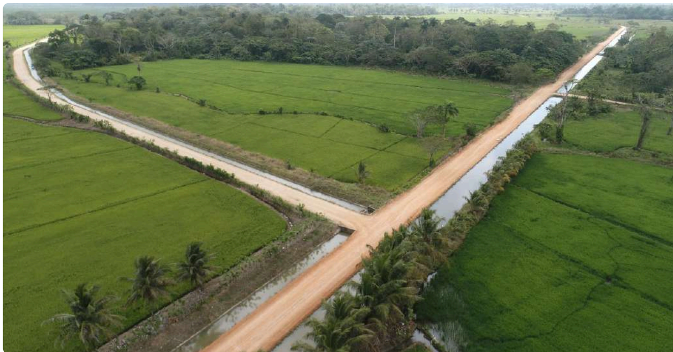
Vista de aérea de canales de riego en el proyecto Aglipo II, provincia Duarte.
