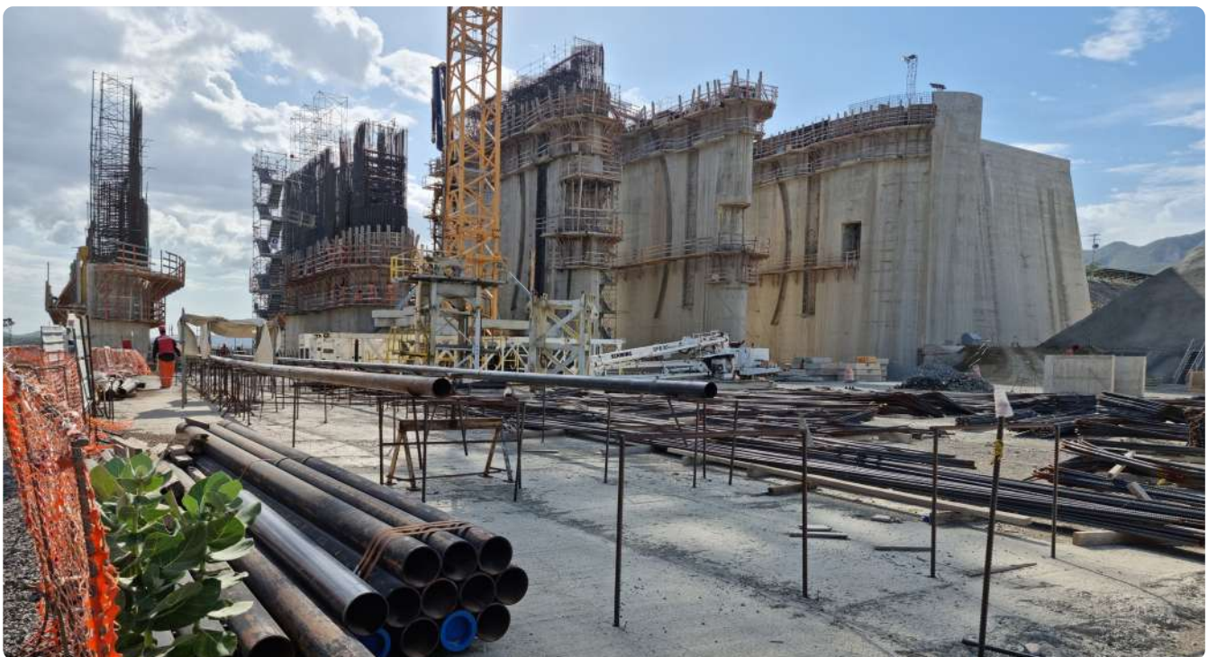
Construcción del vertedero de servicio, presa Montegrande.
