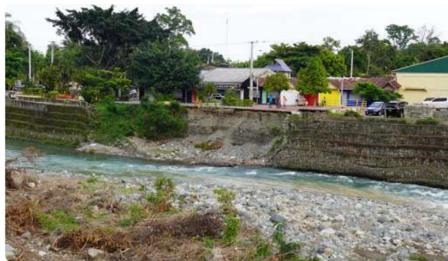
Muro de gaviones que será rehabilitado en la margen derecha del río Yuna. La Salvia - Los Quemados.
