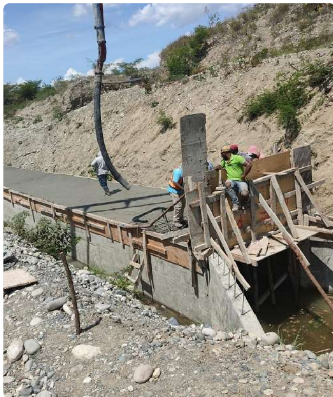
Trabajos de adecuación de la alcantarilla cajón en la desembocadura del arroyo Buringa. Vicente Noble, provincia Barahona.
