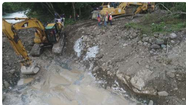
Canalización del río Yuna para rehabilitar el muro de gaviones en la margen derecha. La Salvia - Los Quemados.
