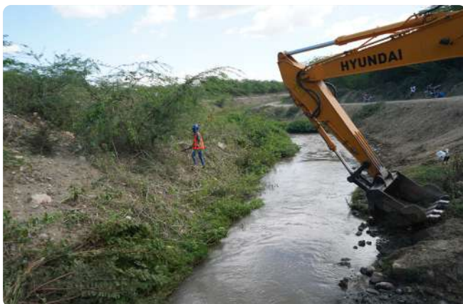
Trabajos de limpieza en el canal Guanito, San Juan.
