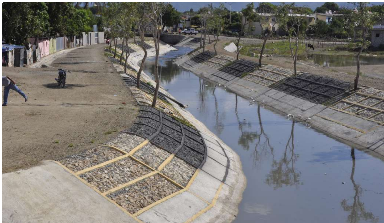
Trabajos finalizados de rehabilitación de la cañada Tengerengue, provincia San Juan.
