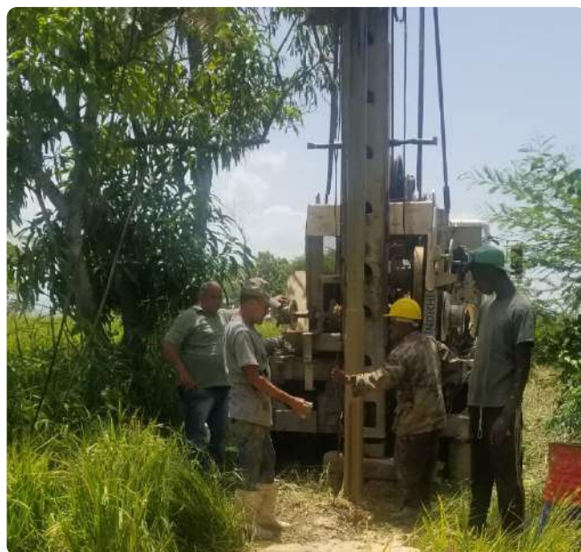
Construcción de pozo tubular en Cardón, distrito municipal de El Rosario, San Juan.
