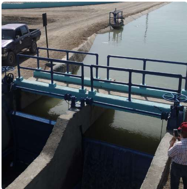
Obra de toma del canal Ysura, sección Tábara Abajo - Proyecto de Desarrollo Agrícola Azua II - Pueblo Viejo.
